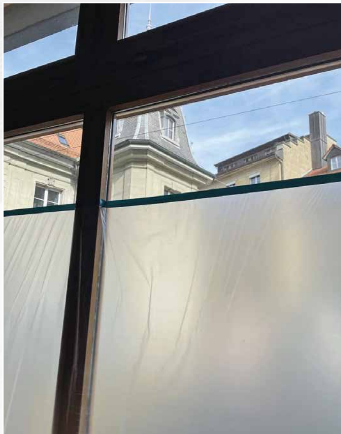
Les travaux d'aménagement intérieur sont prévus ces prochains mois.
